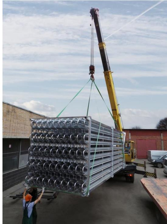
Погрузка атмосферного испарителя ИА-870-4-6.5, матрица 10x10, высота труб 6.5м, номинальная производительность по азоту 3 108  $\text{нм}^3/\text{ч}$
